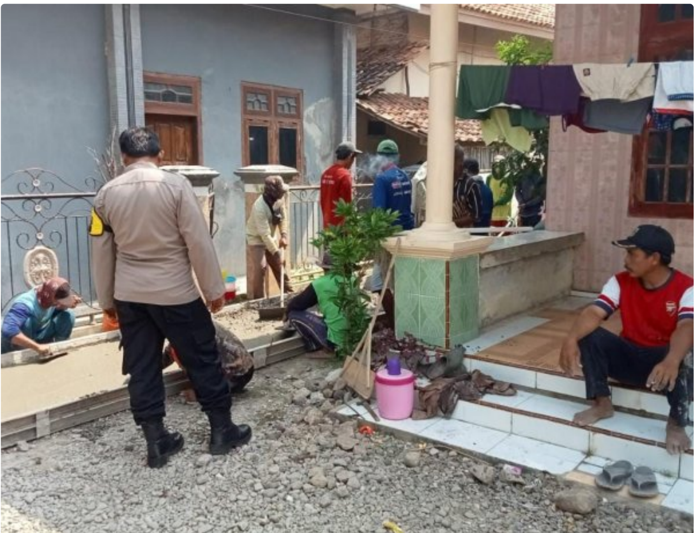
Bhabinkamtibmas Polsek Lohbener Memantau Progres Pembangunan Jalan Setapak
